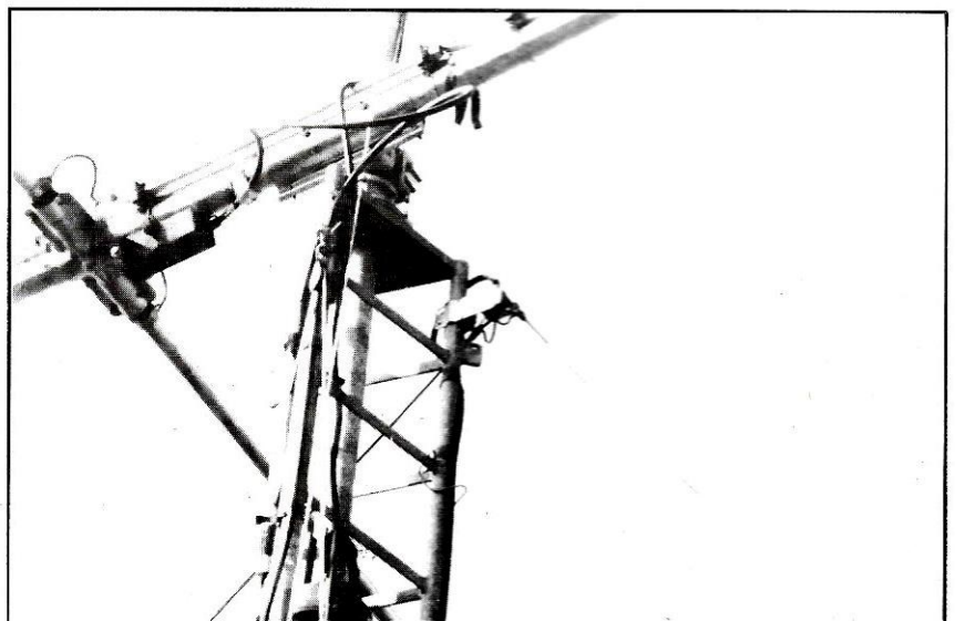
Fixation en haut du pylône.
