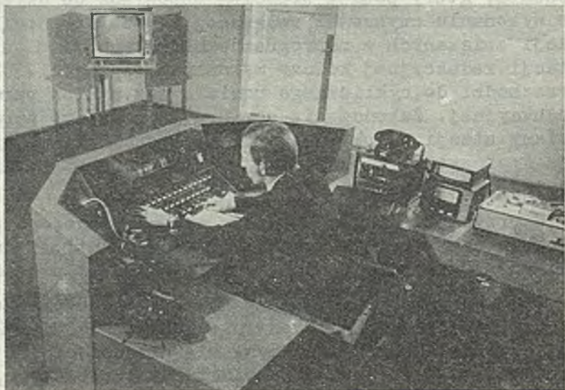
Fot.4. Urządzenie dyspozytorskie w realnych warunkach pracy
